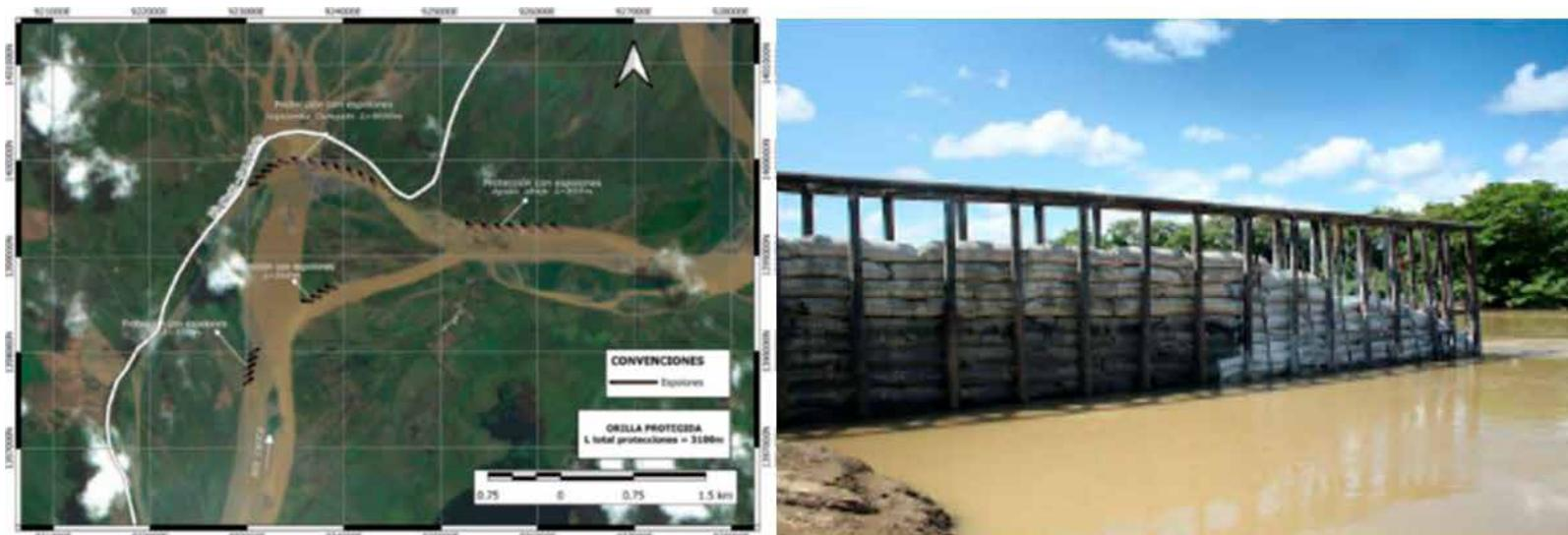
Figura: 4 Alternativa Tecnológica de encauzamiento y protección ribereña con espigones. Fuente: El autor, con apoyo de Hidroconsulta
